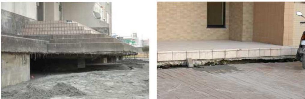
写真 2-3-2 液状化による建物と地盤の段差の発生（出典：浦安震災アーカイブ）
