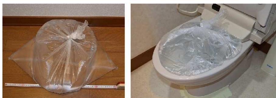
図 2-3-9 トイレ封水の跳ね出し対策
