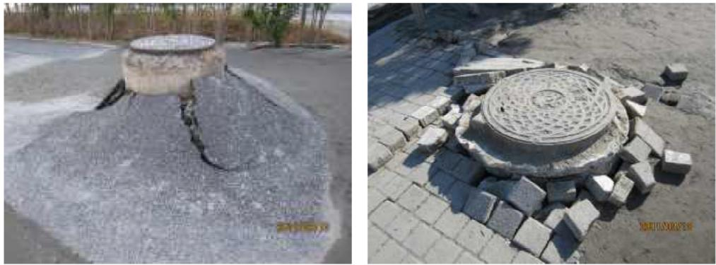
写真 2-3-1 液状化によるマンホールの浮上（出典：浦安震災アーカイブ）
